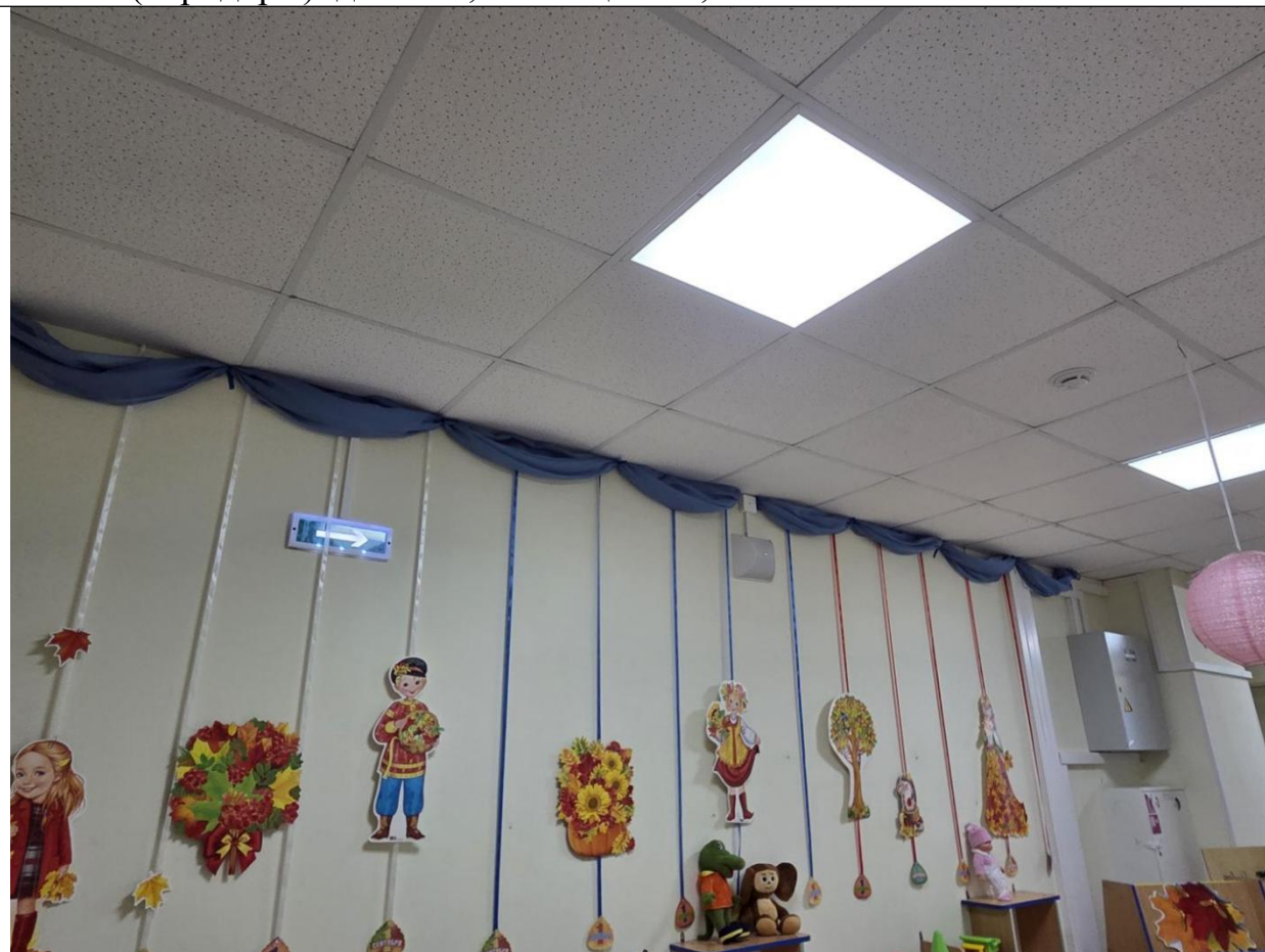
Холлы (коридоры): датчики, оповещатели, световые табло
